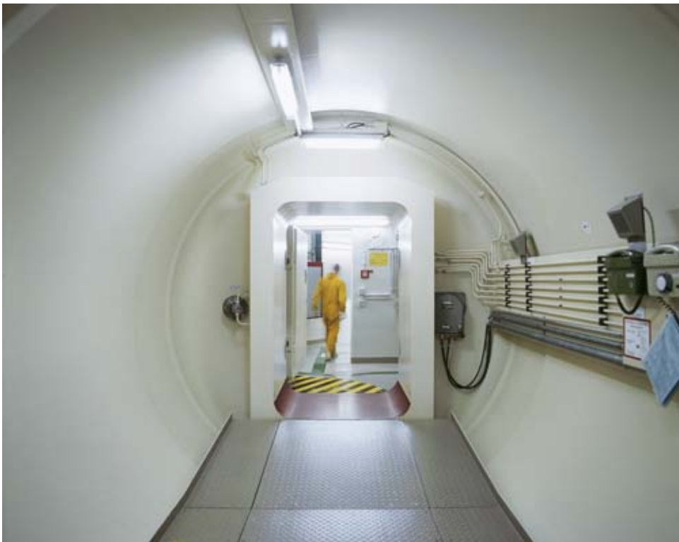
Reaktoria ympäröivän suojarakennuksen sisään kuljetaan ilmatiiviin henkilösulun läpi.
