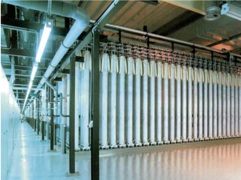
Kuva 5A-3 Isotooppiväkevöinnissä käytettäviä sentrifugeja.
